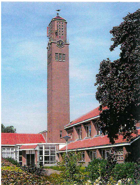
situatie voor aanvang bouw
