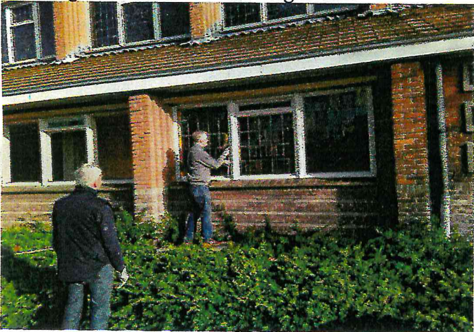
Verwijderen glas-in-lood ramen voor hergebruik in de stilleruimte
